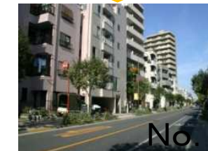
沿道建築物の不燃化 整備後
